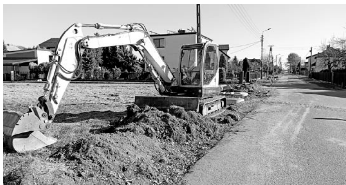
Przebudowa ul. Stawowej w Woli kosztuje 1,2 mln zł
