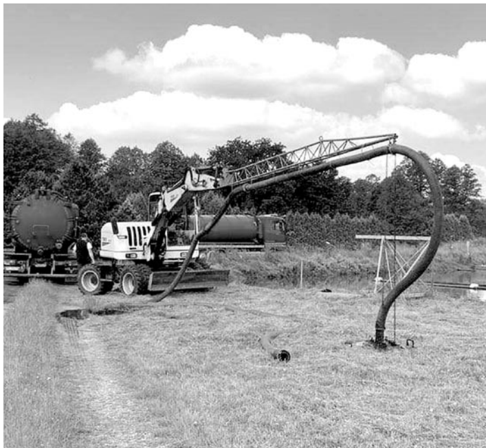
Prace na oczyszczalni przeprowadzono w połowie czerwca (FOT. UG)
