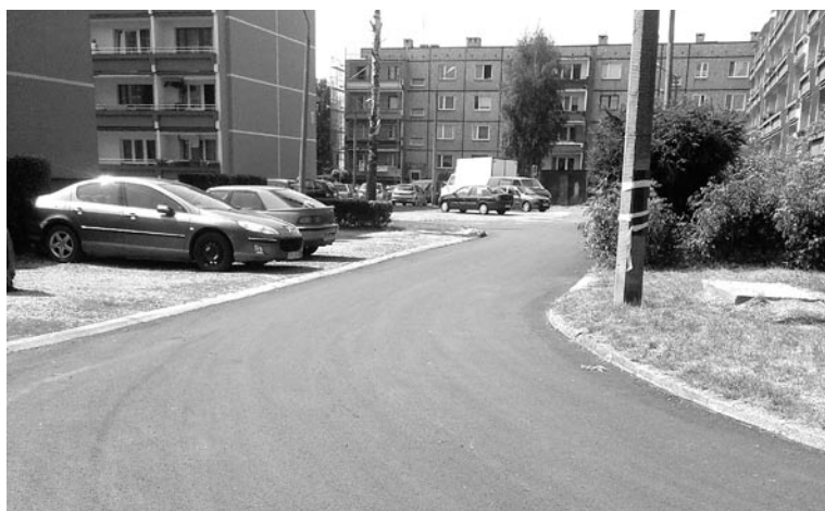
Ul. Górnicza po remoncie
